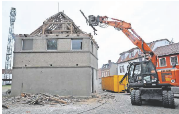
Die Gebäude der Wobag in der Hinterstraße in Grevesmühlen werden abgerissen. FOTO: KARL-ERNST SCHMIDT
